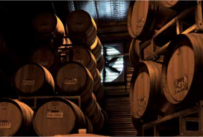
Ci-dessus : chai viticole d’Embres-et-Castelmaure. Le ventilateur, placé derrière une paroi de carton alvéolé humidifié, rafraîchit la cave, un procédé utilisé dans les élevages industriels de poulets.
