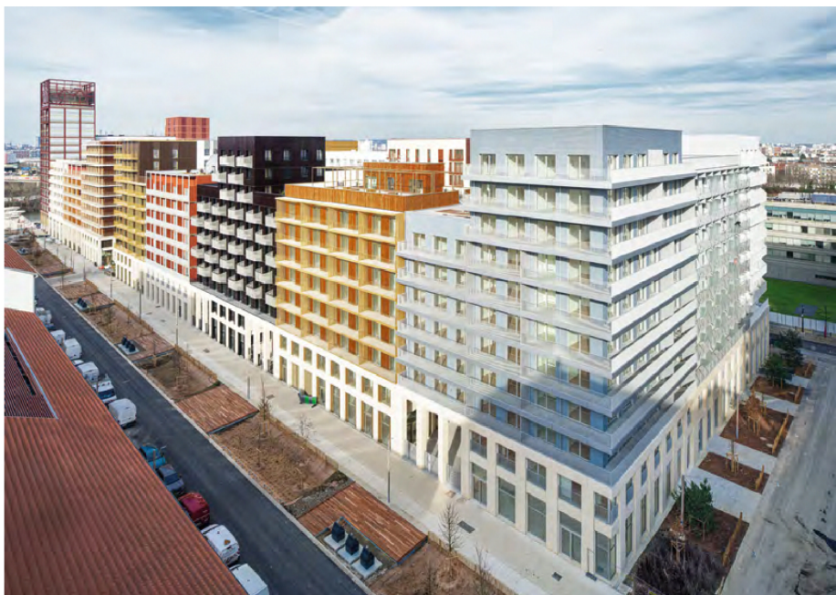
↓ Secteur Universeine : îlot A1 (Clément Vergély coord.) et îlot A2 (Pascal Gontier coord.). Logements de Béal & Blanckaert, Lina Ghotmeh, Pascal Gontier, Gaëtan Le Penhuel, Clément Vergély. Ph. © Takuji Shimmura.
