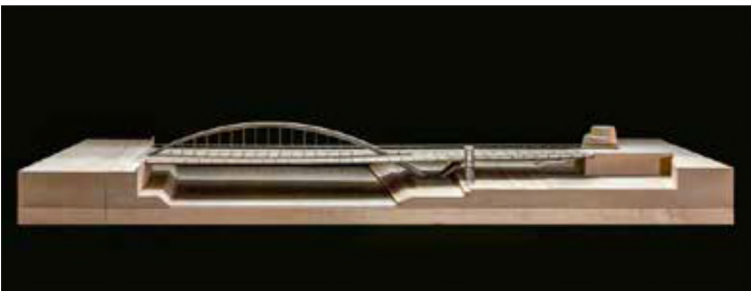
Le pont Seibert reliant l'île Seguin et Meudon (2022). Ci-dessus : la coupe montrant le rapport entre le tablier très large et les arcs surbaissés auxquels il est suspendu, et la maquette qui met en évidence le caractère dynamique des deux arcs qui prennent appui sur le quai haut de l'île pour plonger vers la berge du Bas Meudon et remonter
